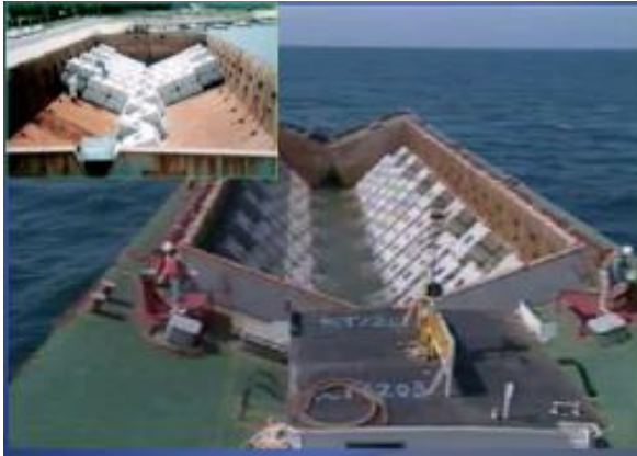
人工海底山脈用ブロックの投入状況
